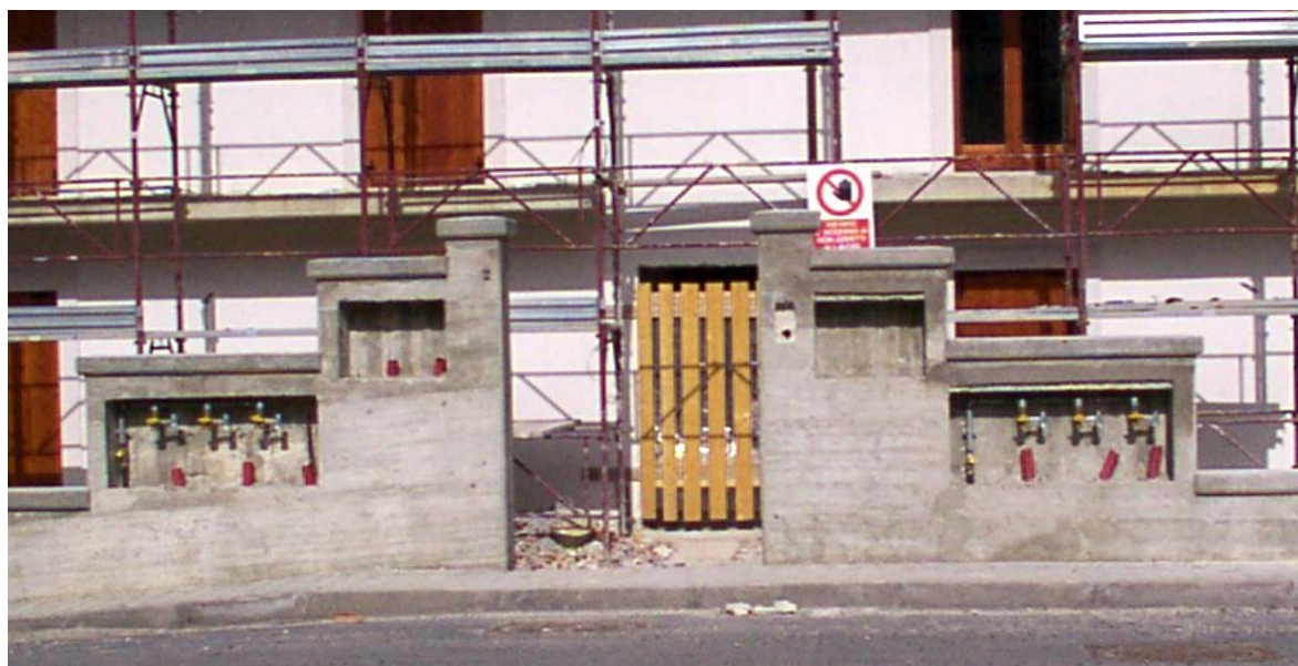
Batterie di contatori su muro di recinzione
