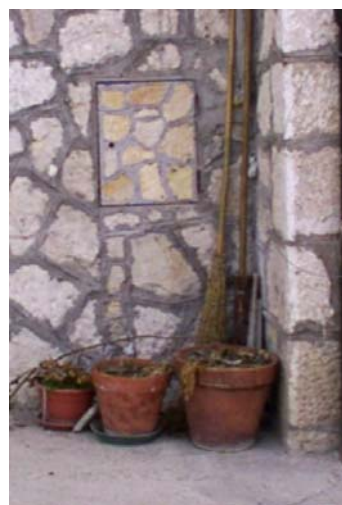
Nicchia rifinita su muro in pietra a vista
